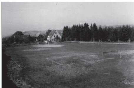
Sportplatz Bolzensteig mit Gasthof Waldhorn
