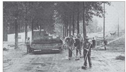
Teerung der neuen Zufahrtsstraße zur Sportanlage
