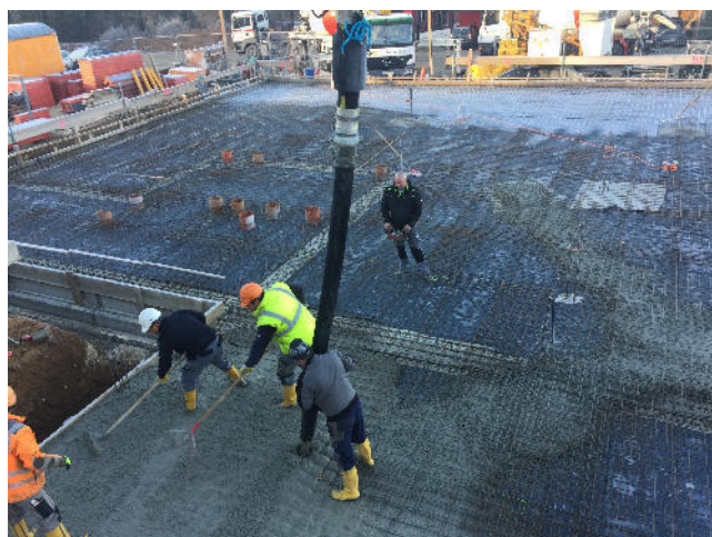
Bild: Betonieren der Bodenplatte)
